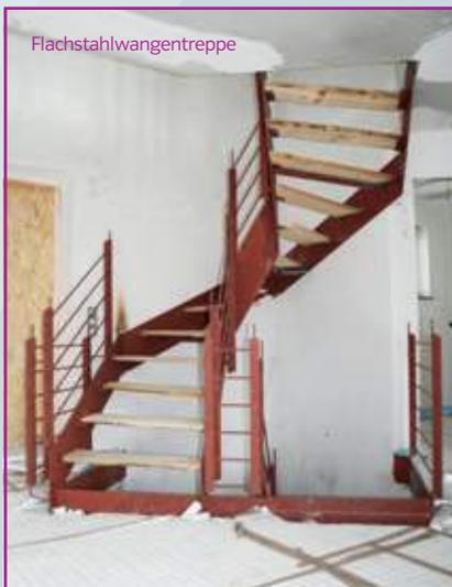
Bei diesem Bildmotiv wurde bereits die Trittschalldämmung verbaut, man kann die Aussparung aber gut erkennen.
